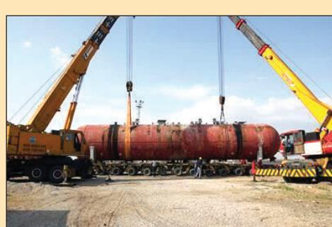
دستگاه نمک گیری بر قی مجهز به میدان الکتریکی (DC/AC) با ظرفیت روزانه ۱۰ هزار بشکه که از سوی کارشناسان شرکت بهره‌برداری نفت و گاز مارون طراحی، بوسازی و راهاندازی شده است، رونمایی و به طور رسمی عملیاتی شد.
