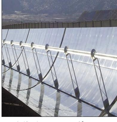
در نیروگاه خورشیدی مرکز کارابی آینه‌هایی، نور به یک سیال تابیده شده و سیال گرم شده برای تولید برق به کار می‌رود. محققان نشان دادند که افزودن گرافن به سیال می‌تواند کارابی تولید برق را در نیروگاه‌های خورشیدی مرکز افزایش دهد.
